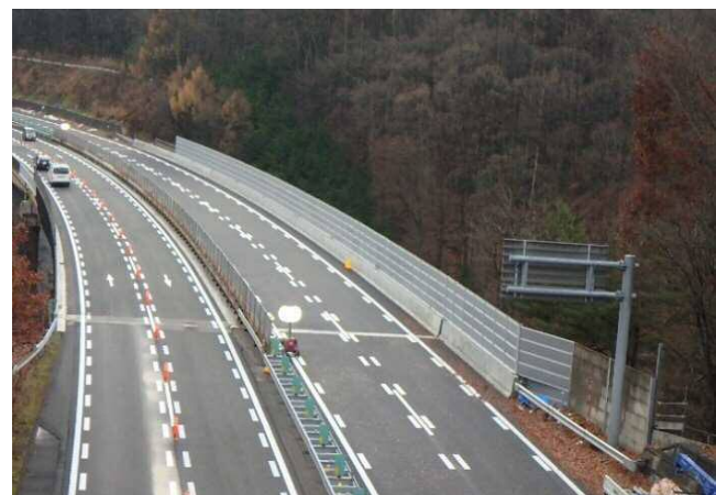
【床版取替完了後】
