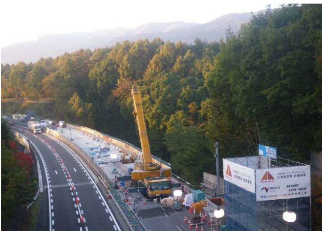
【床版取替工事（全景）】
