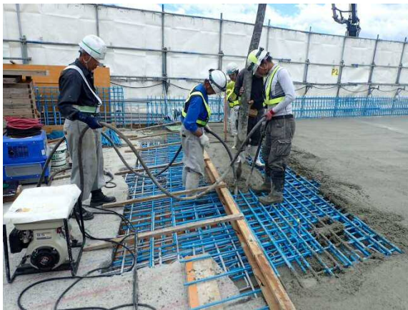
【現場打ち床版の施工状況】
