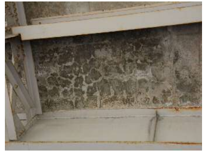
【既存床版の損傷状況】 （ひびわれが発生している）
