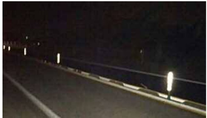
【ラバーポール設置状況（夜間）例】
