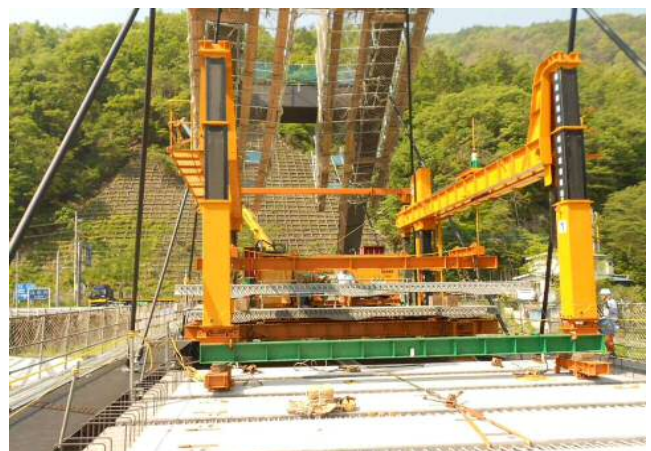
【新しい床版の設置】
