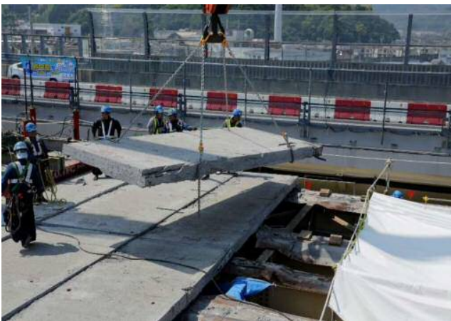
【老朽化した床版の撤去】
