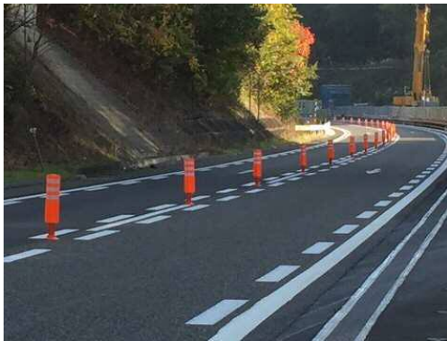
【ラバーポール設置状況例】
