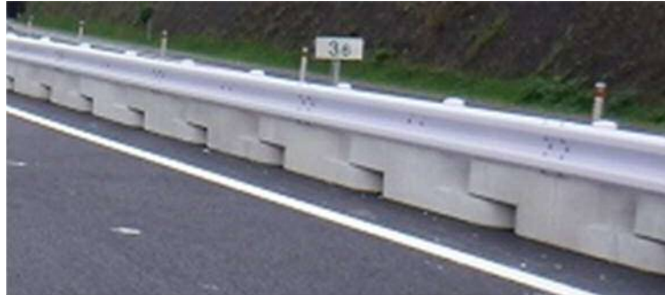
【置き式ガードレール設置状況例】
